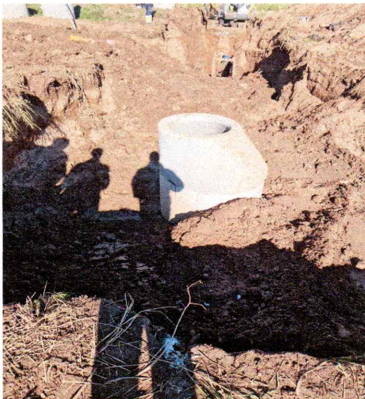
úsek šachta č.2 po osadení
