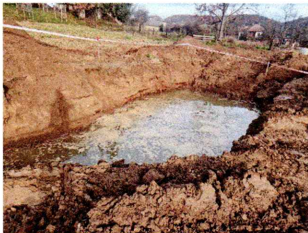
úsek pre osadenie šachty č.8
