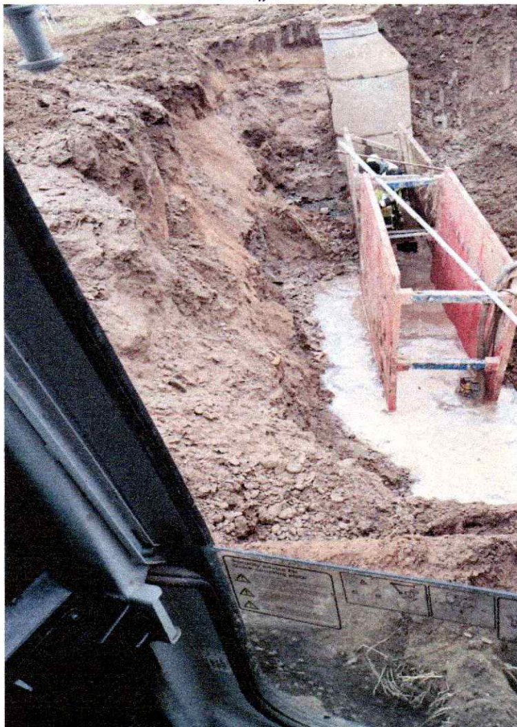
úsek trasy od šachty 47 k šachte 48
